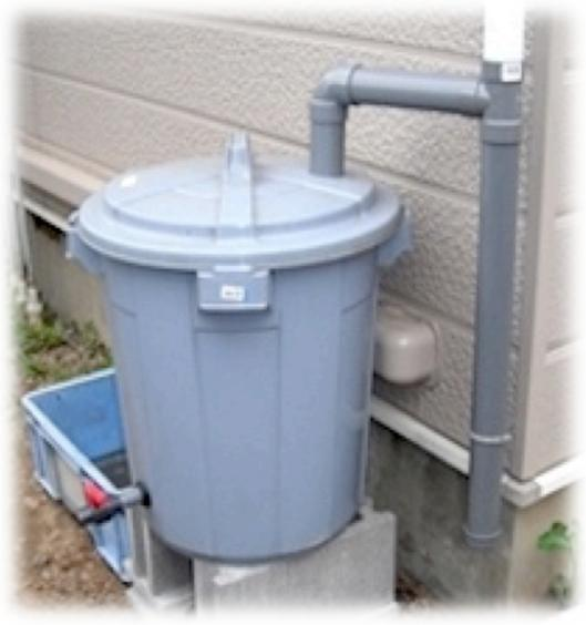
ポリタンクで自作した装置の一例
